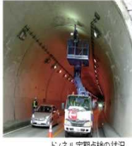
トンネル定期点検の状況
