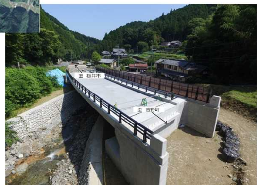
百市工区(橋梁上部工事)
