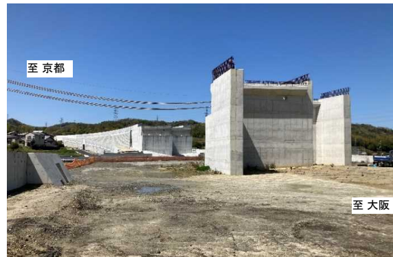
【国道163号】(仮称)下田原東ランプ(橋梁下部工事)
