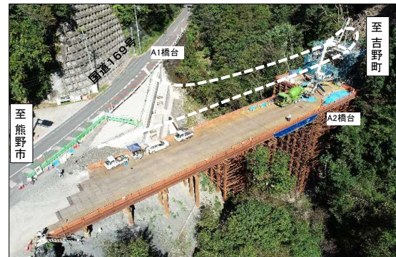
伯母峯峠道路(仮称)2号橋 (橋梁下部工工事)
