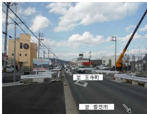
【国道168号】王寺・香芝王寺道路の工事状況
