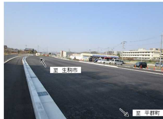
【国道168号】小平尾バイパスの工事状況
