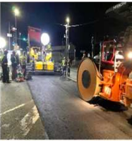
舗装補修工事の状況
