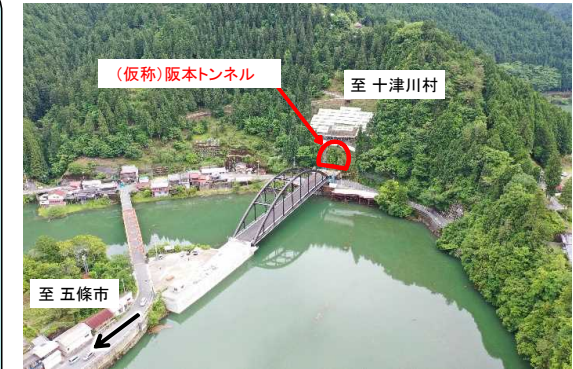
阪本工区・(仮称)新阪本橋
