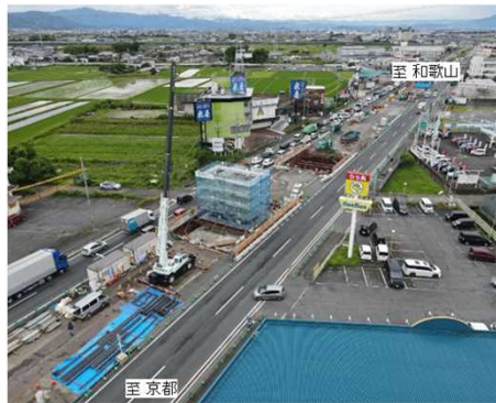
大和北道路(大和郡山市横田町)
