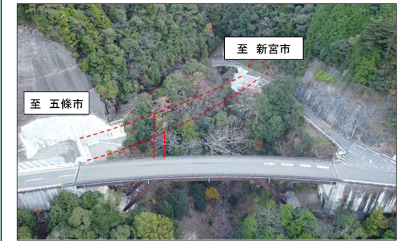
風屋川津工区(仮称)1号橋(橋梁下部工事)
