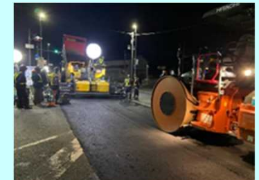
道路の舗装補修
