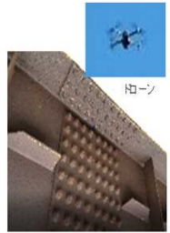
新技術を活用した点検(近接写真の取得が難しかった添接部をドローンで撮影)
