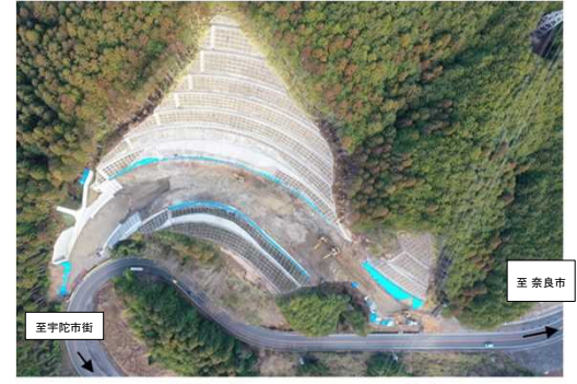
香酔峠工区(法面工事)
