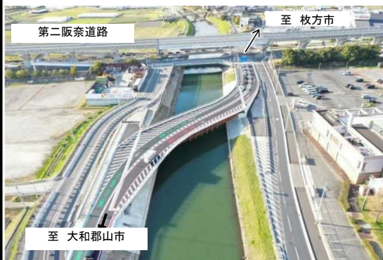
枚方大和郡山線(中町工区)南側
