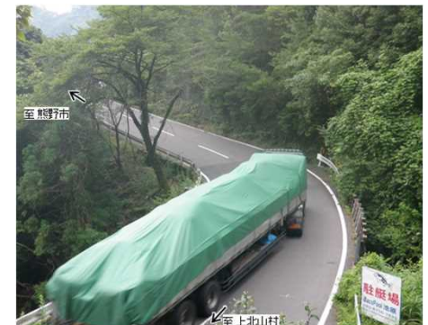
前鬼～音枝 (急カーブ、狭隘箇所)
