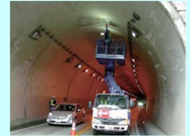
トンネル点検
