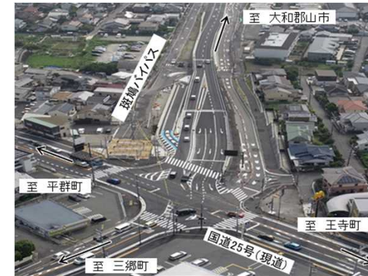
【国道168号】三室交差点の改良工事完成状況
