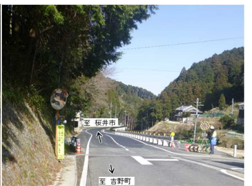
百市工区(部分供用状況)
